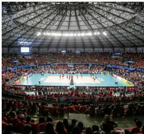
ILUMINAÇÃO LED EM ARENA
