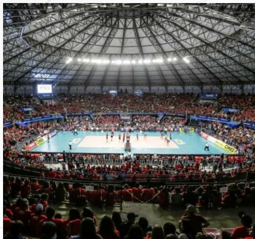
ILUMINAÇÃO LED EM ARENA
