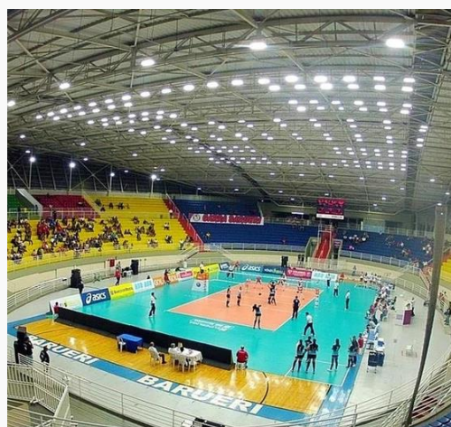
ILUMINAÇÃO LED EM ARENA
