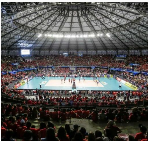
ILUMINAÇÃO LED EM ARENA
