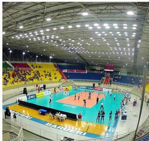
ILUMINAÇÃO LED EM ARENA
