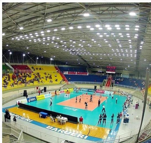
ILUMINAÇÃO LED EM ARENA
