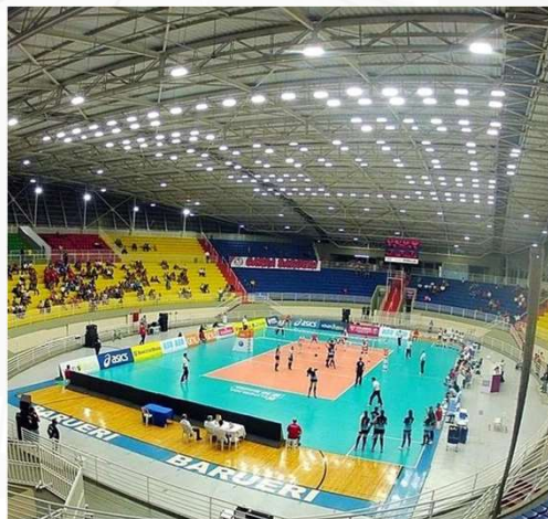
ILUMINAÇÃO LED EM ARENA
