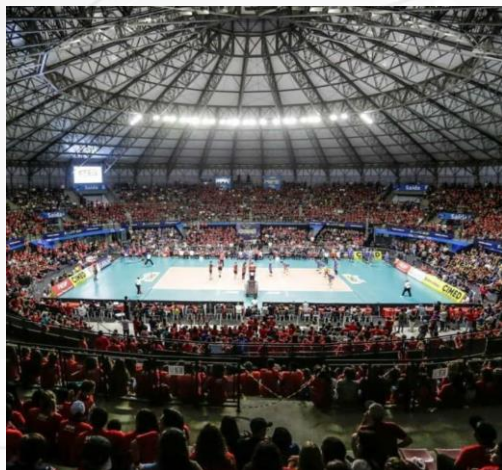
ILUMINAÇÃO LED EM ARENA
