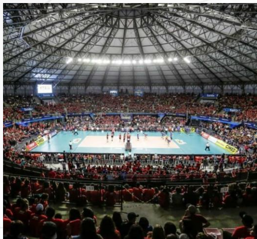
ILUMINAÇÃO LED EM ARENA
