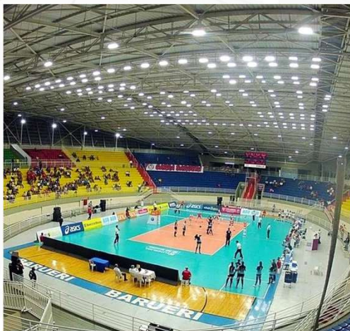
ILUMINAÇÃO LED EM ARENA
