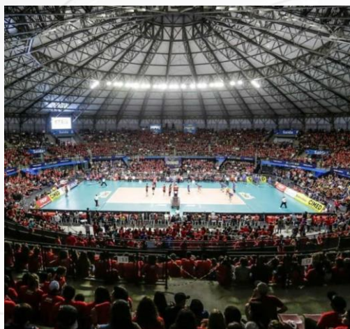
ILUMINAÇÃO LED EM ARENA
