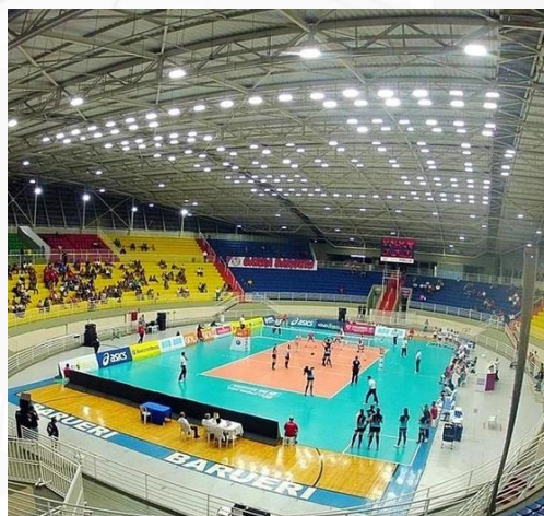
ILUMINAÇÃO LED EM ARENA
