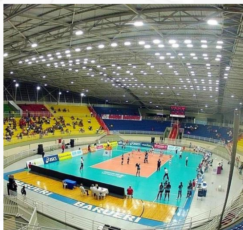
ILUMINAÇÃO LED EM ARENA
