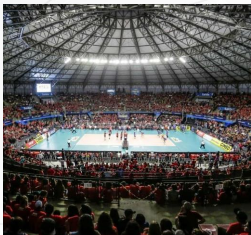
ILUMINAÇÃO LED EM ARENA
