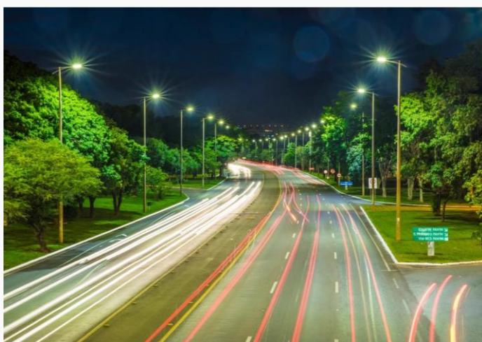
ILUMINAÇÃO LED EIXO RODOVIÁRIO
